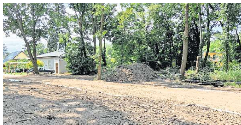
Fünf Bäume fielen für die Baustraße in der Verlängerung der Roseggerstraße in Teltow-Seehof.
